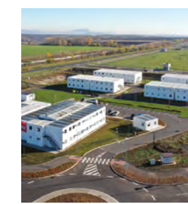
Dormitory / ubytovací zařízení
