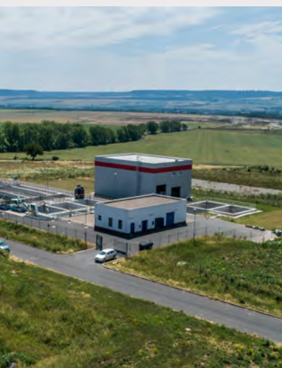
Water treatment plant and chemical plant for cleaning technological wastewaters / čistírna splaškových a technologických vod
