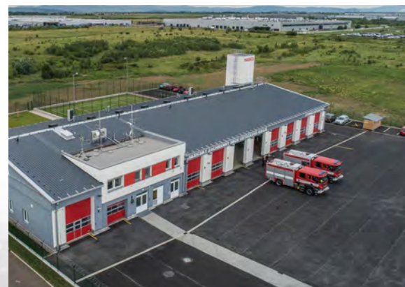
The Fire station / hasičská stanice
