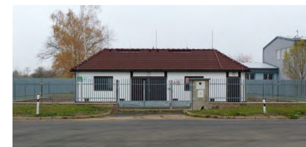
The regulation gas station / regulační stanice plynu
