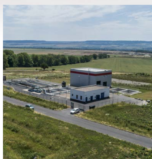
Water treatment plant and chemical plant for cleaning technological wastewaters / čistírna splaškových a technologických vod
